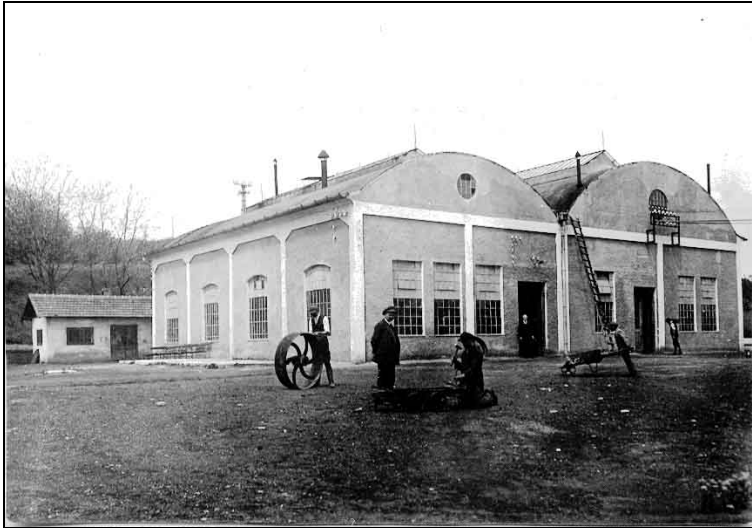
Az ormospusztai szénbánya villamos erőművének épülete.
