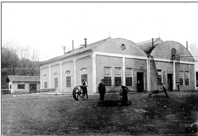
Villamos centrálé, kazánházzal.
