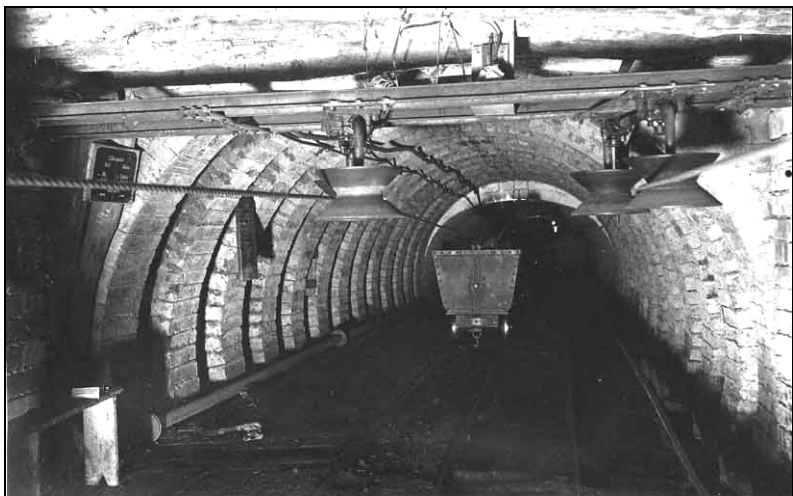
Betonműkövekkel boltozott lejtősakna-szakasz.
