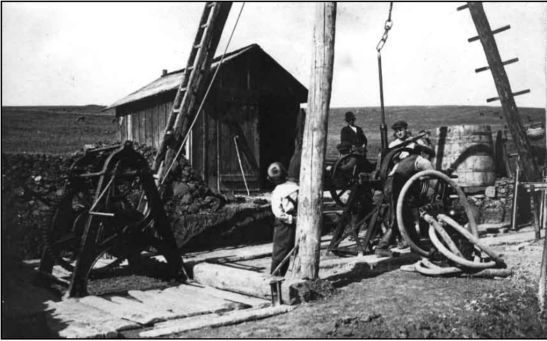
Craelius rendszerű mélyfúrógép üzemben.
